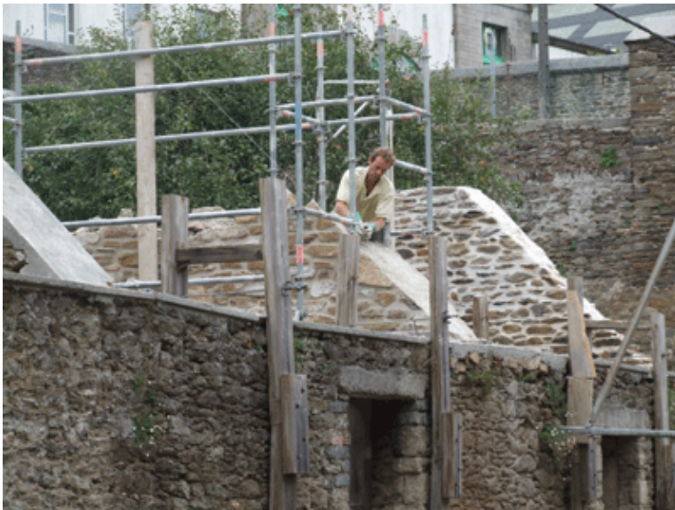
Le chantier en cours, photo de Mireille Cann.
